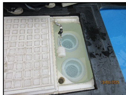
รูปที่ 47 ระบบระบายน้ำล้น
