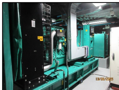
รูปที่ 14 เครื่องจ่ายสำรองไฟ (Generator)
