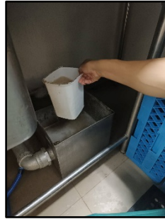
รูปที่ 20 การตัดไขมันในถังดักไขมัน
