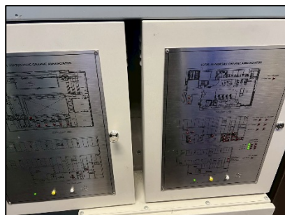
ระบบควบคุมสัญญาณแจ้งเหตุเพลิงไหม้
