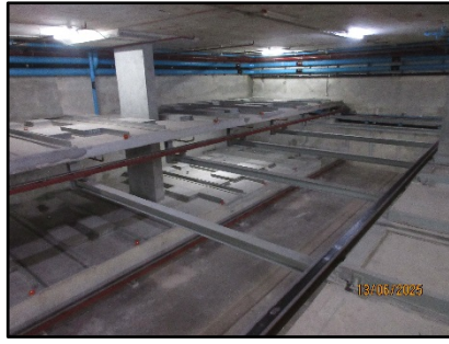
รูปที่ 15 ระบบจอดรถอัตโนมัติ
