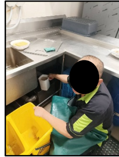
รูปที่ 20 การตัดไขมันในถังดักไขมัน
