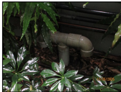
รูปที่ 21 ท่อระบายอากาศจากระบบบำบัดน้ำเสียเพื่อกำจัดละอองเสียด (Aerosol)
