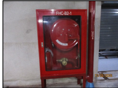
รูปที่ 16 ระบบป้องกันอัคคีภัยภายในระบบจอดรถอัตโนมัติ
