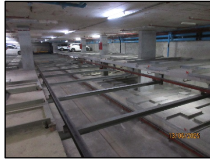
รูปที่ 15 ระบบจอดรถอัตโนมัติ
