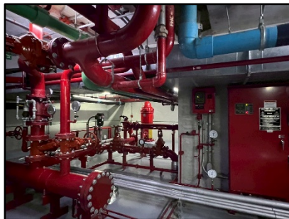
รูปที่ 40 ระบบสำรองน้ำดับเพลิง
