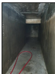
รูปที่ 18 การล้างทำความสะอาดถังเก็บน้ำใช้
