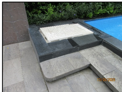
รูปที่ 47 ระบบระบายน้ำล้น
